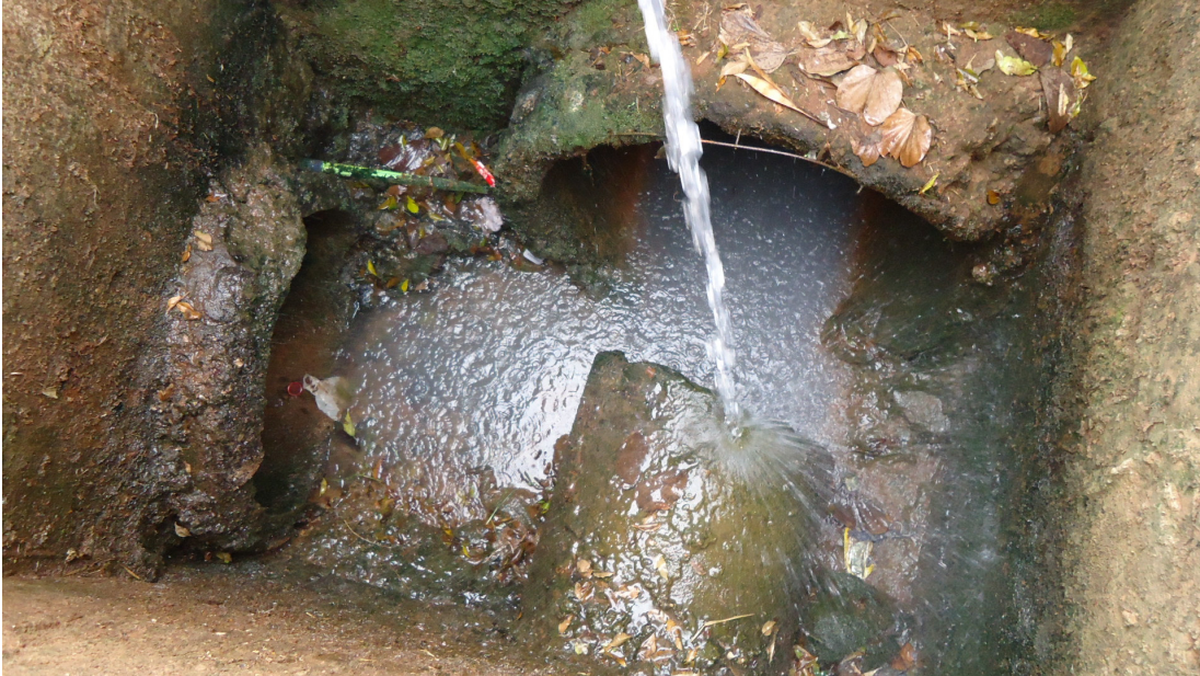
Figura 5.12 – Água cinza na rede pluvial. Tio Hugo.
