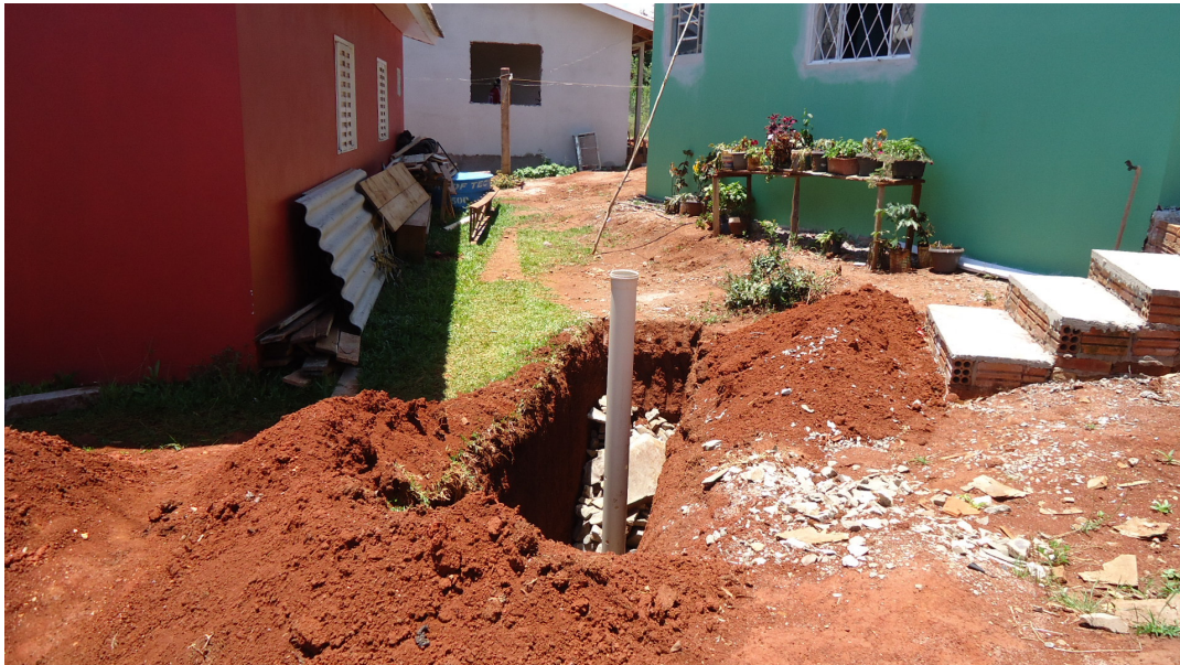
Figura 5.9 – Construção de sumidouro na zona urbana de Tio Hugo.
