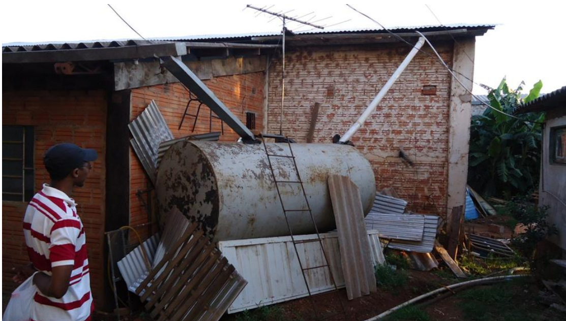
Figura 6-10 - Iniciativas de captação e armazenamento de água de chuva.
