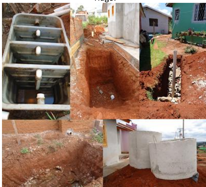
Figura 4-3 – Construção de fossa séptica e sumidouro na zona urbana de Município de Tio Hugo.
