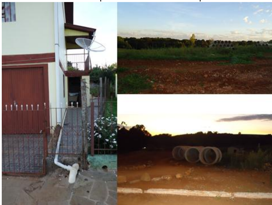
Figura 6-5 - Tubos para a implantação de sistema de drenagem pluvial e ligação de água cinza na rede pluvial existente sob a via pública.
